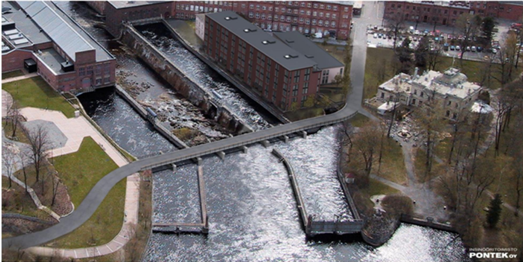
Palatsinraitin kevyen liikenteen silta ja patoportit Valokuviasovitus ilmakuvaan pohjoisesta
